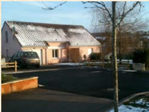
Lotissement des Sorbiers : aménagement d'une place et d'un parking
