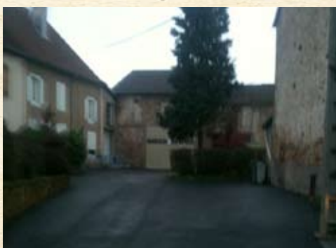
Réfection de la rue des Terres Rouges
